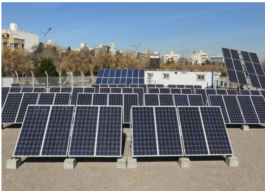
شکل ۳: نمایی از ۱۸ کیلووات سیستم فتوولتائیک متصل به شبکه
