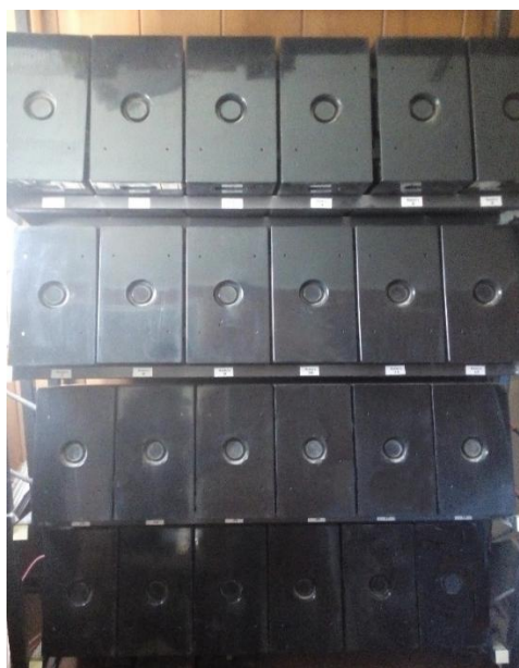
شکل ۲: نمایی از ۳۰ کیلوولت آمپر باتری سرب اسید سیستم مستقل از شبکه
